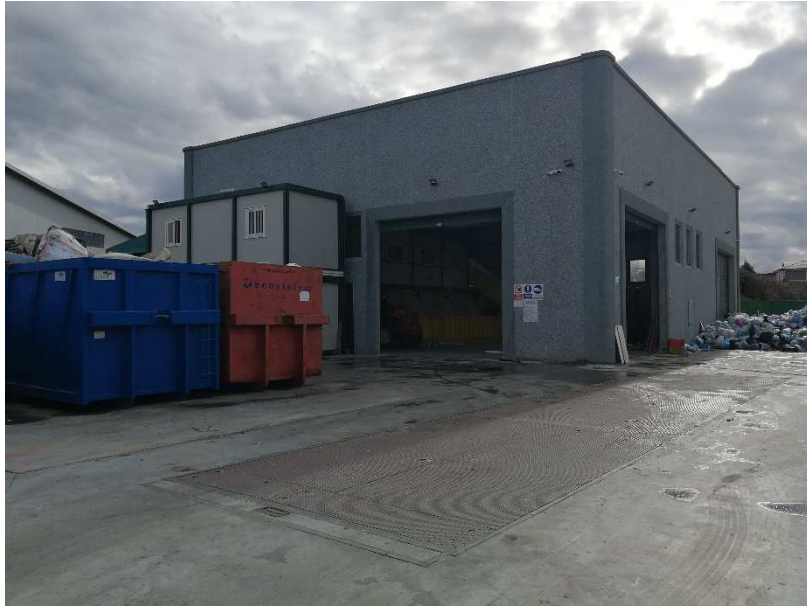
Figura 7 - Prospetto principale impianto di trattamento dei rifiuti
